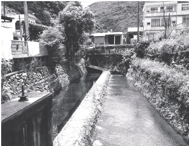
明渠導水路及側向溢流堰（溢流道）：左邊的水圳是灌溉用水，當水量溢出中間的潛堰漫過右邊的水圳，便回流林邊溪。
