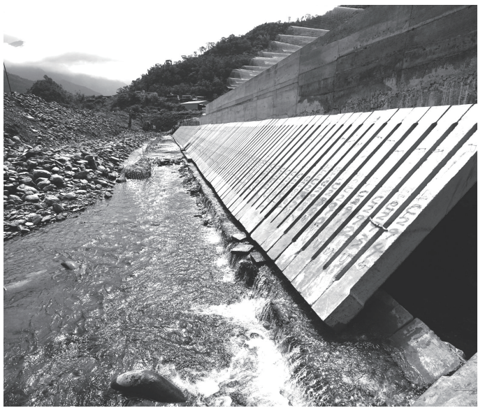
2017年4月，屏東林邊溪二峰圳整修期間露出的堰堤。
