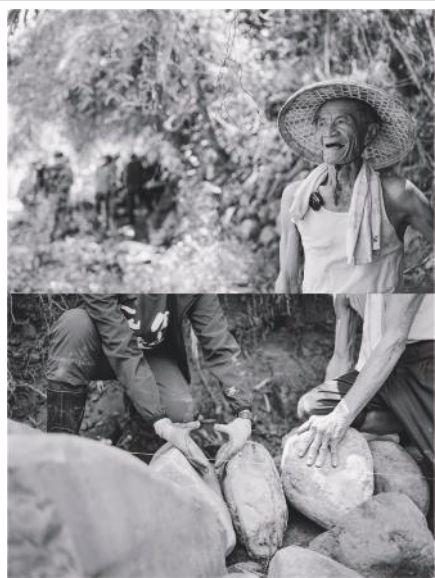
在地耆老謝阿伯分享自己過去的經驗，現場指導如何用溪床的鵝卵石堆砌護岸邊坡。
